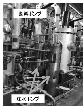
図3 注水ポンプ及び燃料ポンプ
